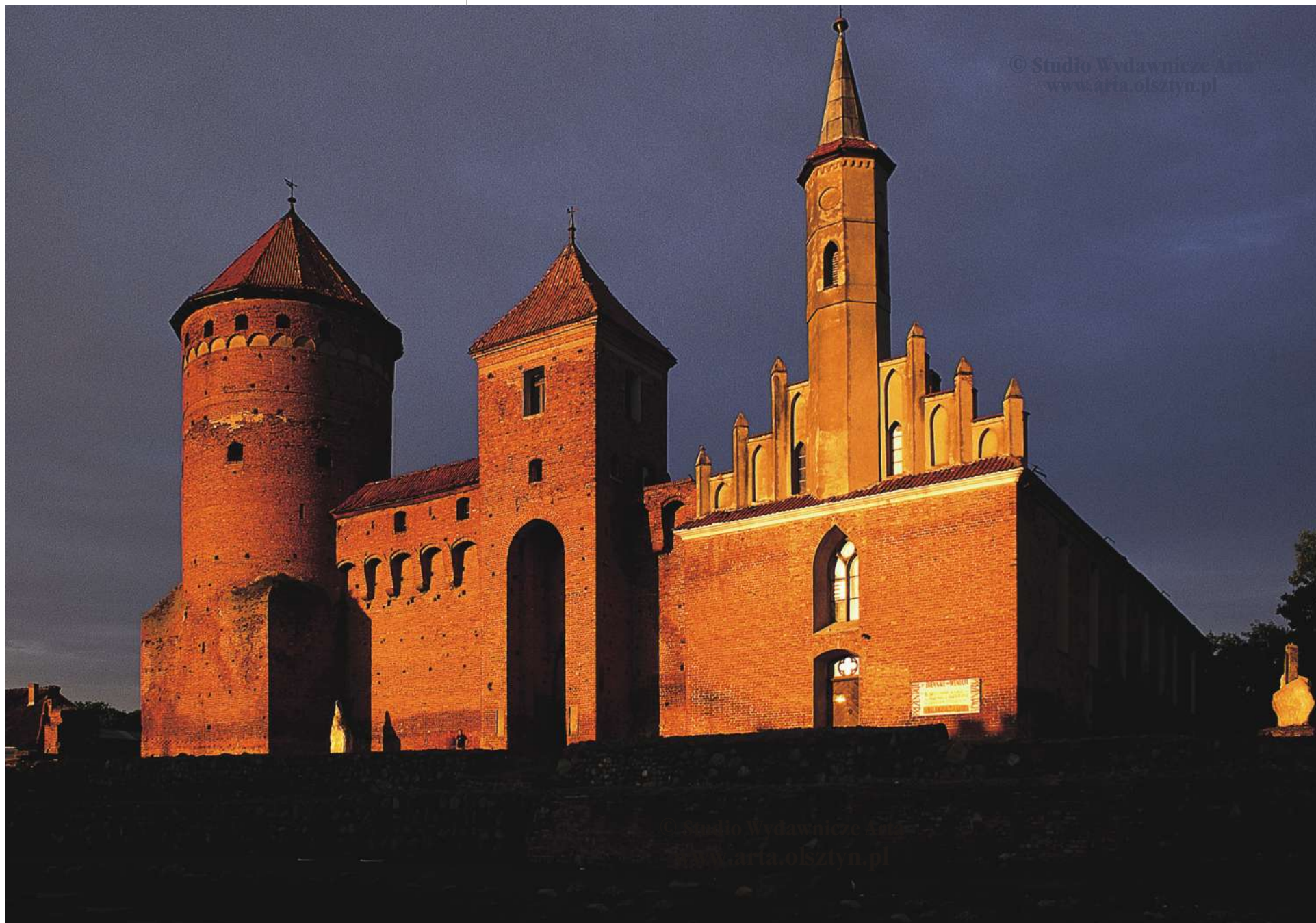
Hauptfassade der Burg im Westen
