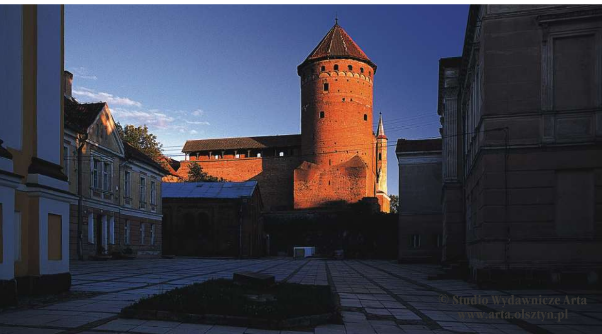
Widok na zamek od północy, z dziedzińca dawnego kolegium jezuickiego
