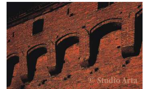
Machikuły pod gankiem obronnym
