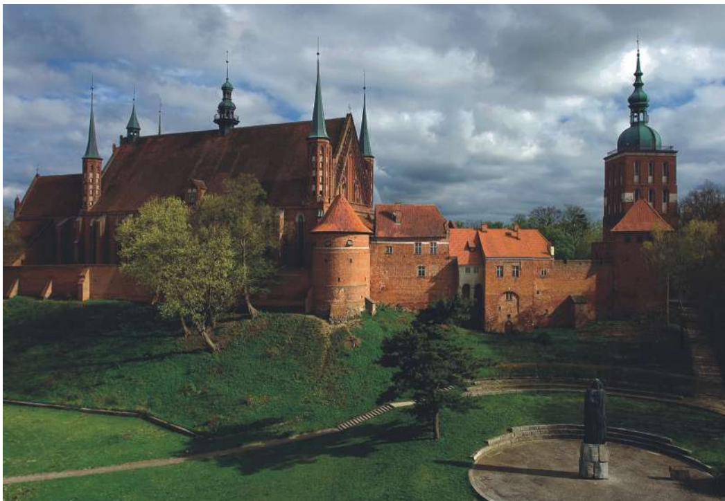
Widok na wzgórze katedralne ze średniowiecznej Wieży Wodnej (od północy)
