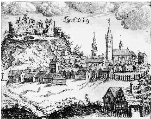
Stich aus der Sammlung Ch. Hartknoch, 1684, Ansicht von Südwesten
